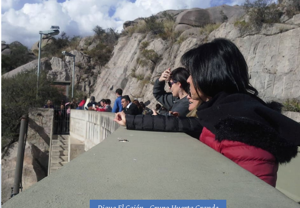
Dique El Cajón - Grupo Huerta Grande
